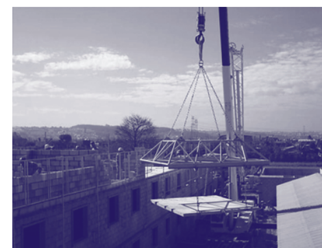
Processo de produção e transporte das lajes pré-fabricadas para os edifícios da Cury Construtora em Mogi das Cruzes, apresentado por David Nonno na 11ª Conferência Internacional LARES, em 2011. (Acervo da Cury Construtora, 2011.)
