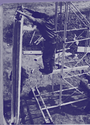
Sobre o guincho, o operário orienta a colocação dos painéis já justapostos
