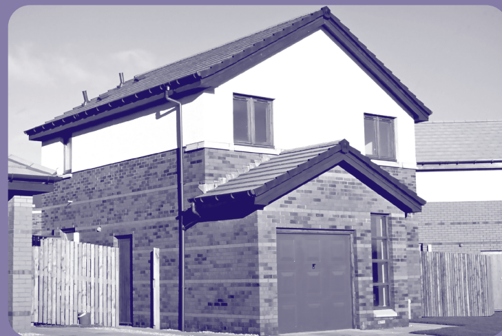
Nos Gorbals de Glasgow, uma torre pré-fabricada de vinte e quatro andares é preparada para a demolição. Enquanto isso, surge no subúrbio o novo 'lar ideal para a família ideal' produzido em massa. (Fotos do autor, 2008 e 2000.)
